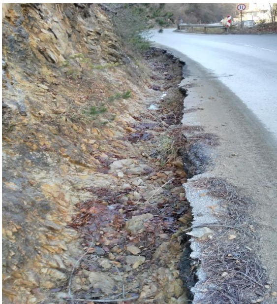
Фигура 18 Образувал се от ерозията окоп в участъка от път III-868 след кръстовището за с. Смилян.
